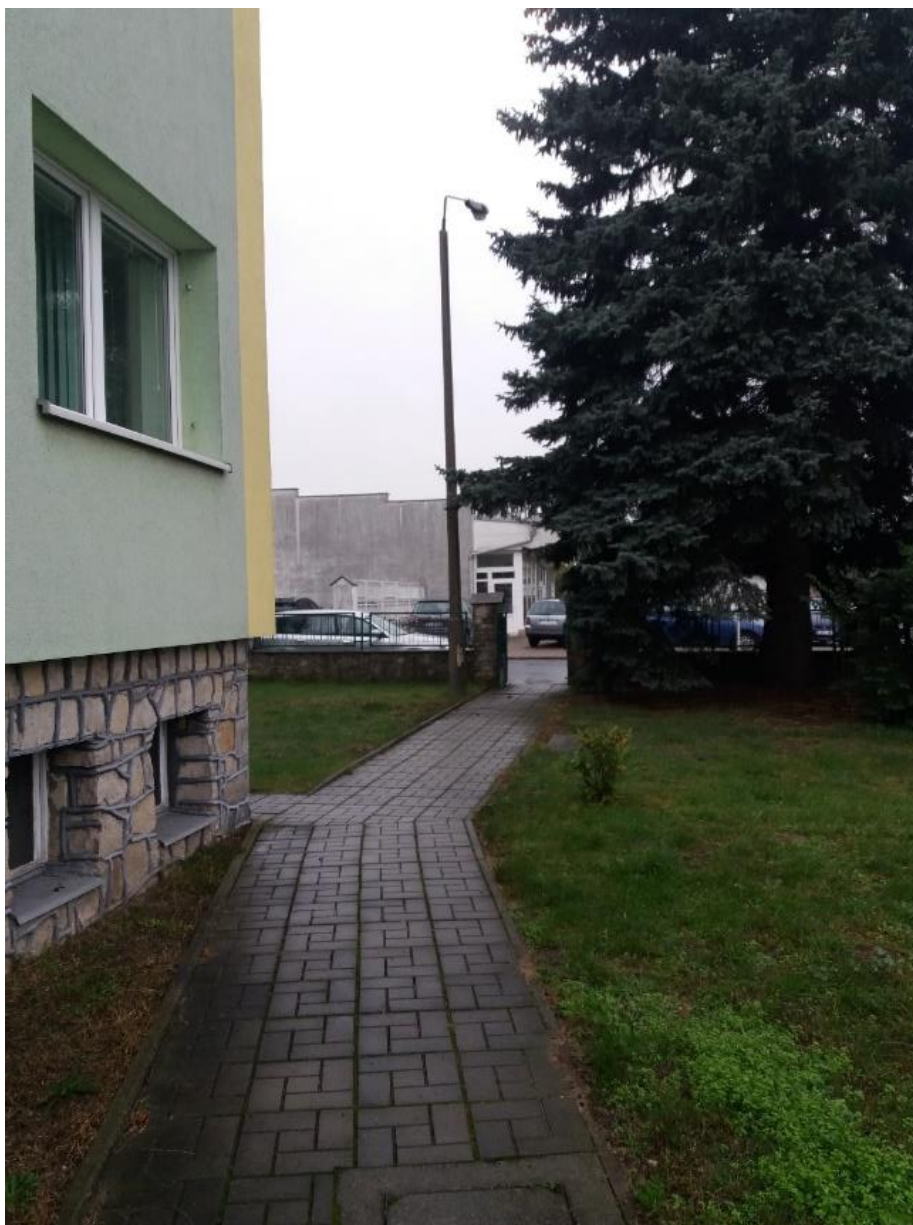
Na trasie dojść do wejść do budynku występują stopnie prowadzące ku drzwiom.
